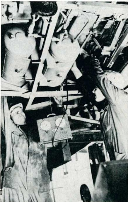
Unter einem Bus während der routinemäßigen Inspektion. Die Hebebühnen ermöglichen ein aufrechtes Arbeiten. Die Bewegungsfreiheit ist wesentlich größer als bei den früher allein üblichen Gruben unter dem Niveau des Hallenbodens.
