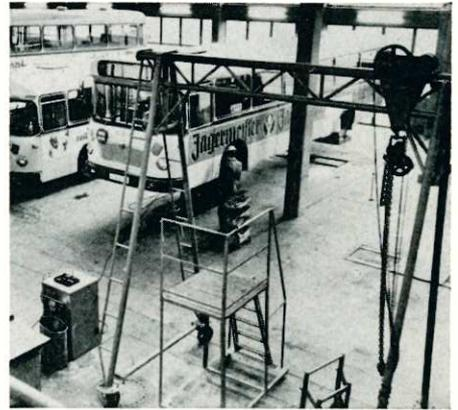
Wichtiges Hilfsmittel in der Werkstatt ist das Hebegerät (im Vordergrund rechts). Ohne dieses Gerät oder ohne die Anwendung eines Flaschenzuges wäre es beispielsweise kaum möglich, schnell eines der schweren Räder zu wechseln.
