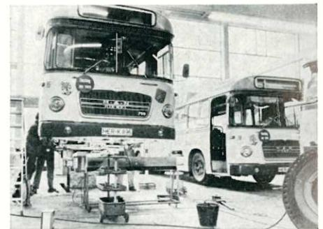
Moderne hydraulische Hebebühnen erleichtern die Arbeit unter den Bussen. Nur in der sogenannten Inspektionshalle gibt es noch die Grube.
