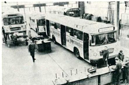
An vielen Bussen gleichzeitig kann in der großen Werkstatthalle gearbeitet werden. Bei eingefahrenen Hebebühnen bietet der Hallenboden eine große ebene Fläche. Mühelos können dann die schweren Fahrzeuge rangiert werden.
