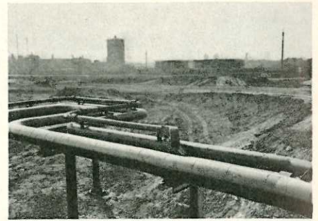
Blick auf die beginnende Dammschüttung für den Auffahrtsarm B 51/Eickeler Straße. Im Vordergrund Rohrleitungen der Hibernia, die durch das Bauwerk im Zuge der Eickeler Straße über die Zechenbahn bereits verlegt wurden. Im Hintergrund die Anlagen der Hibernia-Chemie.
